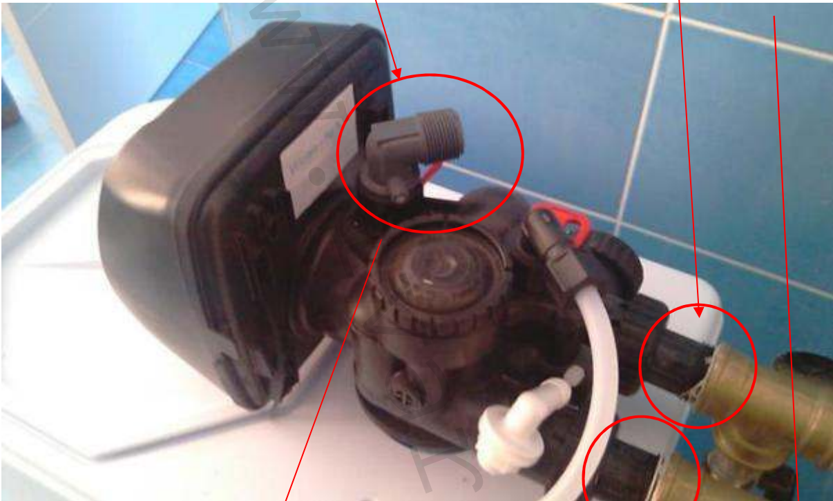
Zapojení dvou odpadů do kanalizace:
