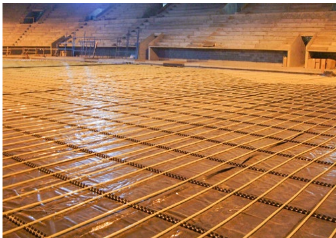
Instalace trubek do hřebenových lišt IVAR.WL
