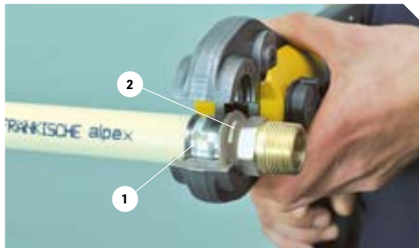
Pohled na správně provedenou lisovací operaci trubky IVAR.ALPEX s lisovacím fitinkem IVAR.PRESS 1. detail otisku lisovací kontury „B“ při použití čelistí REMS 2. správná poloha trubky po lisování
