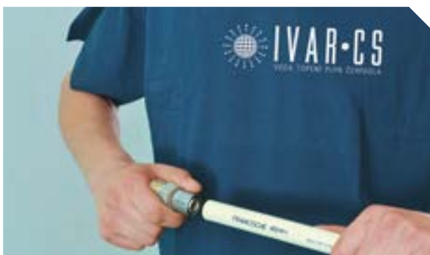
Nasunutí lisovacího fitinku IVAR.PRESS na zkalibrovanou a odhrotovanou trubku IVAR.ALPEX.
